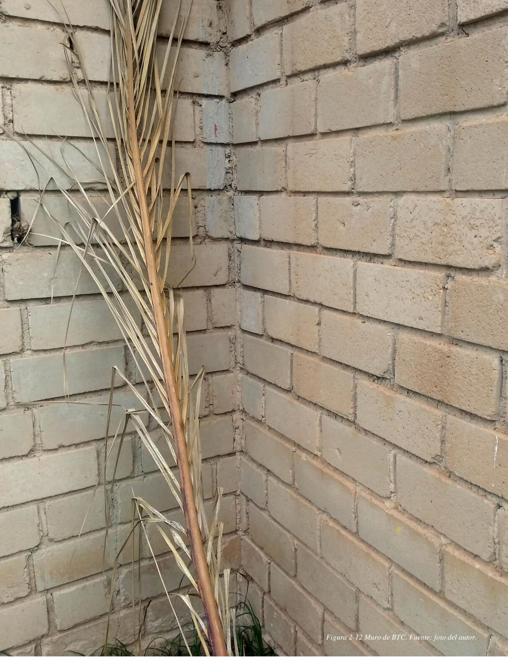
*Figura 2-12 Muro de BTC. Fuente: foto del autor.*
